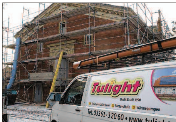
Auf der Baustelle: Die Tulight-Fahrzeuge mit ihrem markanten Logo stehen an der eingerüsteten „Villa Germania“. Die Samariteranstalten lassen ihr denkmalgeschütztes Gebäude zur Tagungsstätte ausbauen.
