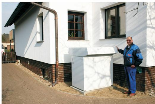
Für Andreas Tulke hat sich nach der Wärmebedarfsberechnung und der Erstellung des Energieausweises die Luft-Wärmepumpe als die richtige Alternative erwiesen. Die Gasheizung wurde abgebaut. Damit spart er pro Jahr etwa 1.100 Euro für Heizkosten..
